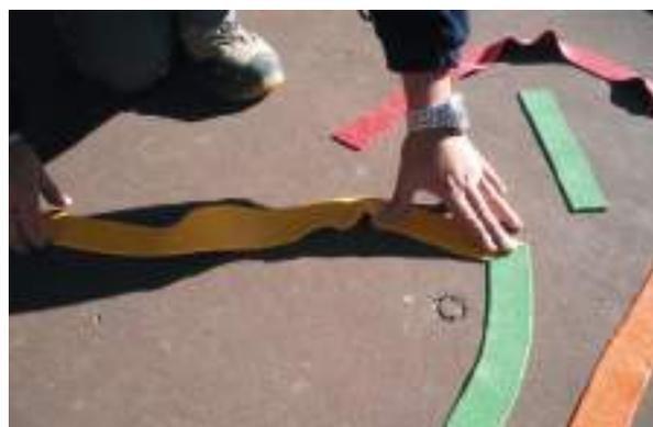
Bend & Shape(\*), simple à manipuler, rapide à appliquer - vous avez juste besoin d'un balai et d'un chalumeau
